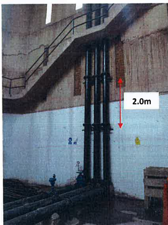
FIG. 24: SEPARACIÓN DE ABRAZADERAS EN TUBERÍAS ADOSADAS
