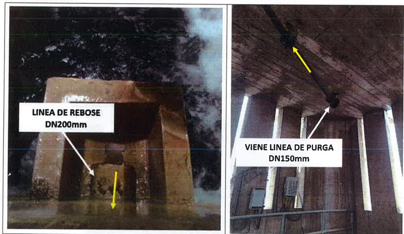
FIG. 27: LÍNEA DE REBOSE Y PURGA DEL R-256
