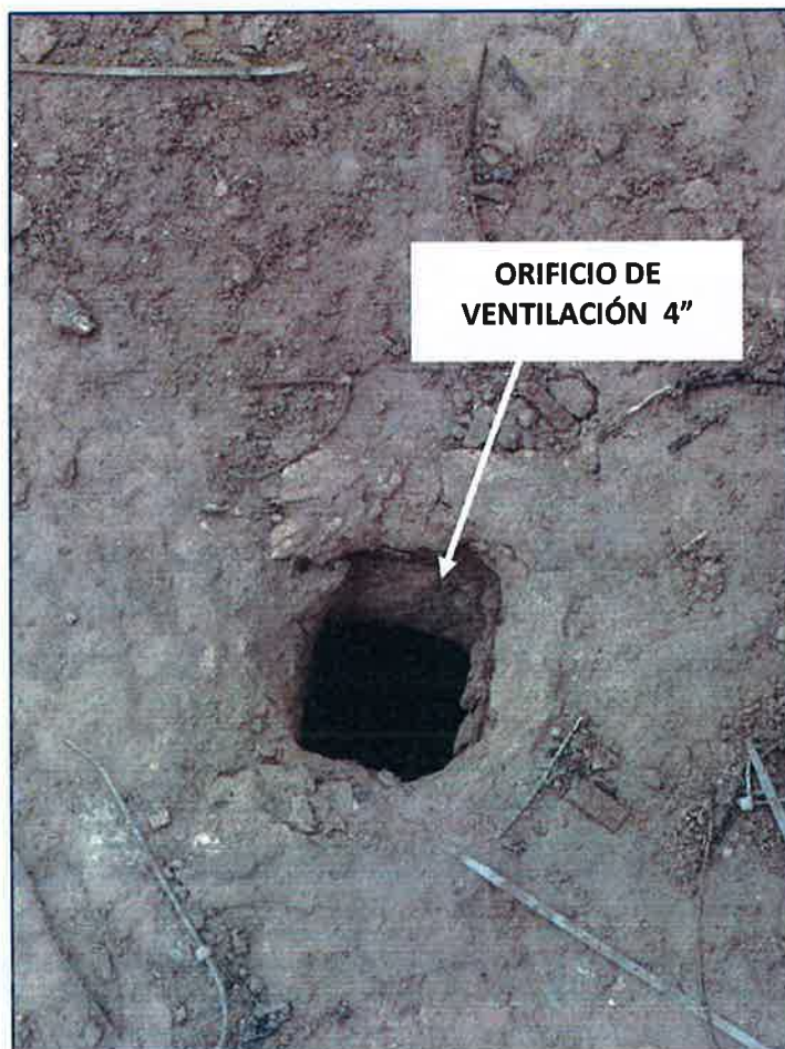
FIG. 31: VENTILACIÓN DEL R-256
