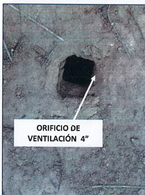
FIG. 43: VENTILACIÓN DEL R-257
