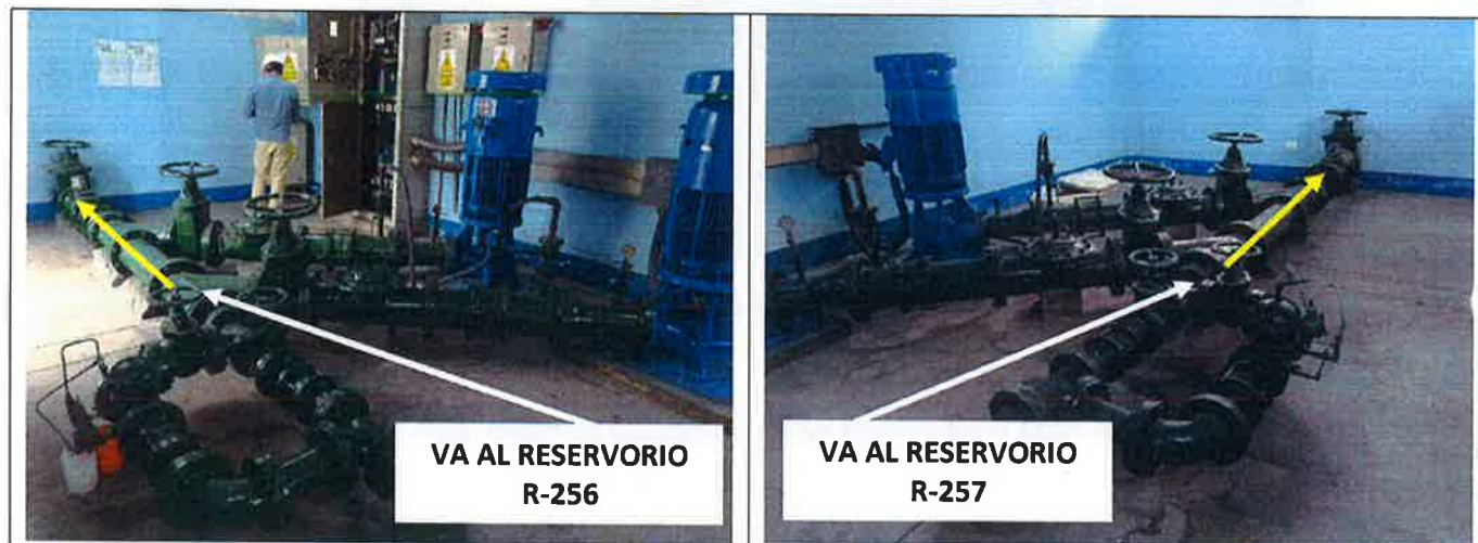
FIG. 46: IMPULSIÓN DE LA CISTERNA CR-148
