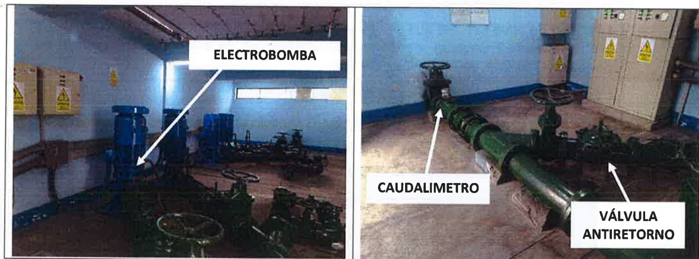
FIG. 45: SISTEMA DE BOMBEO DE LA CISTERNA CR-148
