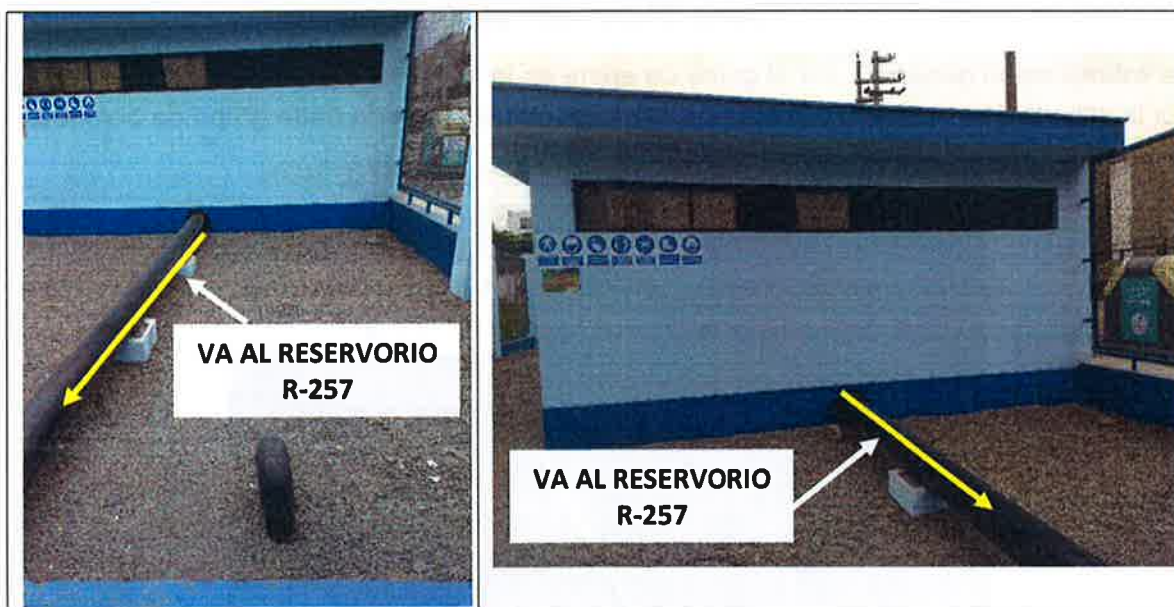
FIG. 48: LÍNEA DE IMPULSIÓN AL RESERVORIO R-257
