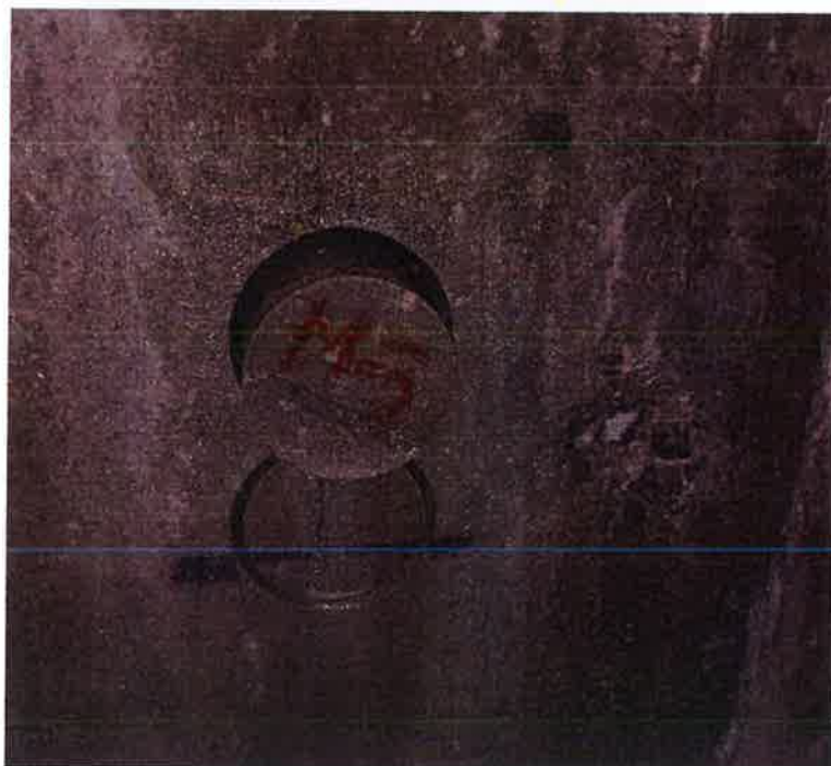
FIG. 10: EXTRACCIÓN DE MUESTRA DE DIAMANTINA EN PARTE INFERIOR DE LA CUBA
