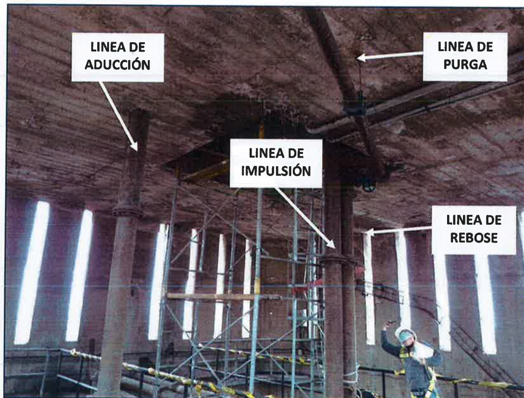
FIG. 35: UNIONES ENTRE TUBERÍAS
