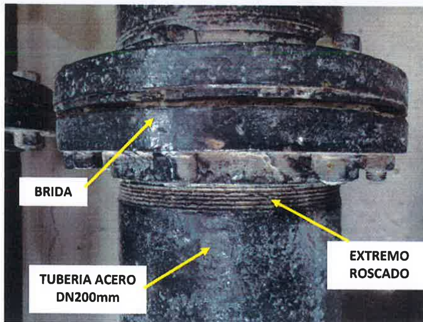
FIG. 35: UNIONES ENTRE TUBERÍAS
